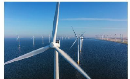
Doc. 11 Une éolienne convertit l'énergie cinétique du vent en énergie électrique et en énergie thermique (non voulue).
